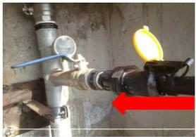
**PASO 3** Conectar la lanza (conexión macho) a la toma de servicio, y comprobar que está el seguro colocado.
